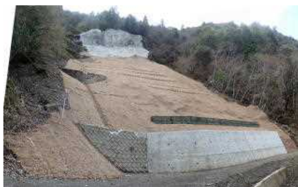
令和3年度山腹工 完成（大又国有林）
