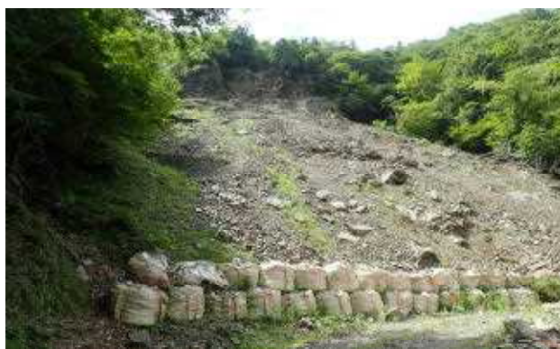
令和3年度山腹工 施工前（大又国有林）
