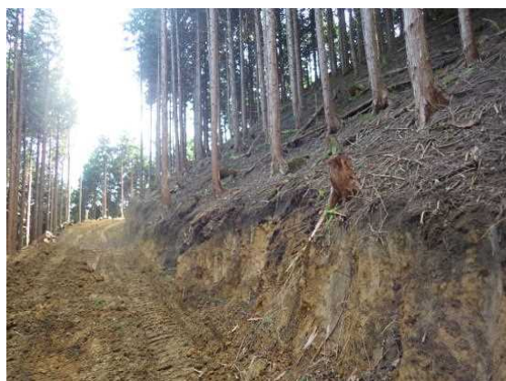
森林作業道作設（悟入谷国有林）
