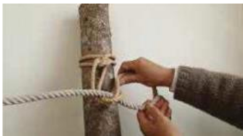
5：トックリ結び（防護柵上ロープ通す）
