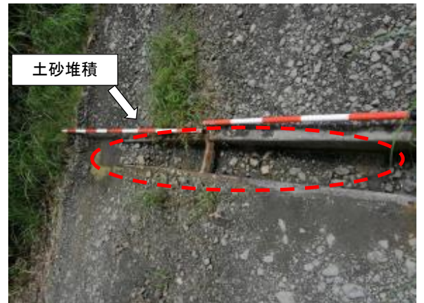
横断溝の点検
