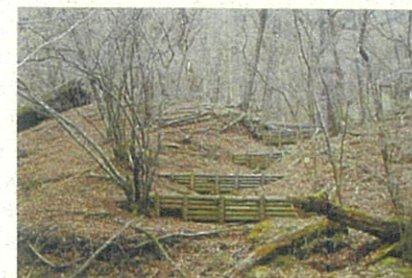
写真4 勾配の緩和による手法（丸太柵工）
