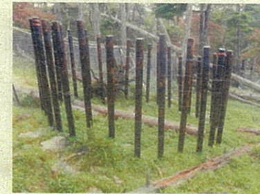
写真1 杭を使用した植生保護柵
