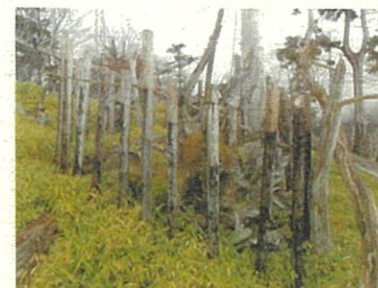
写真 8-3 ハッチディフェンス （丸棒加工杭防鹿柵）
