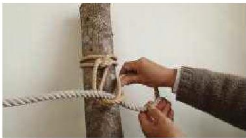
5：トックリ結び（防護柵上ロープ通す）
