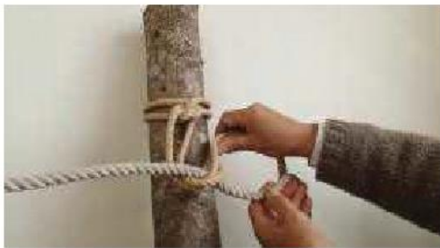
5：トックリ結び（防護柵上ロープ通す）
