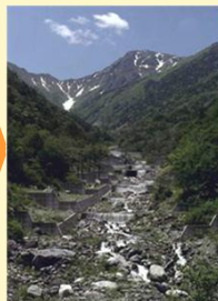
工事実施後(S62)
