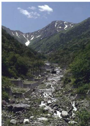
工事実施後(S62)
