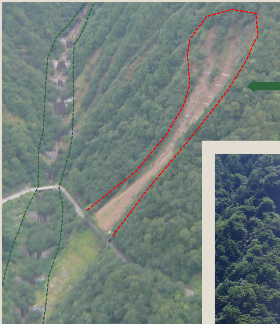
《赤沢地区復旧状況H25》
