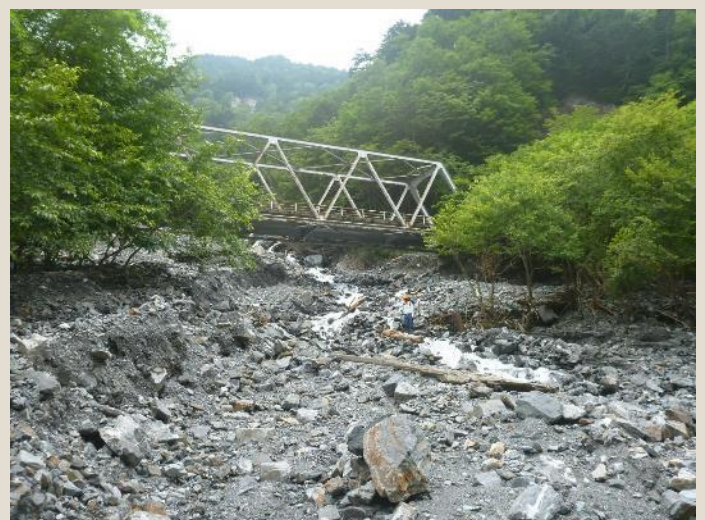
《橋梁周辺の状況》
