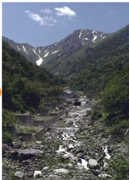
工事实施後(S62)
