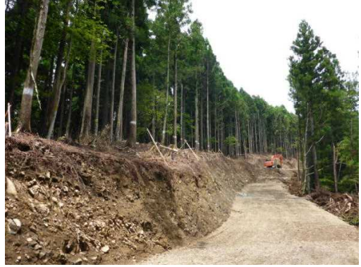
上佐野国有林内林道新設工事
