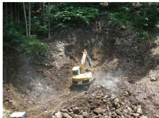
板垣山国有林治山現場
