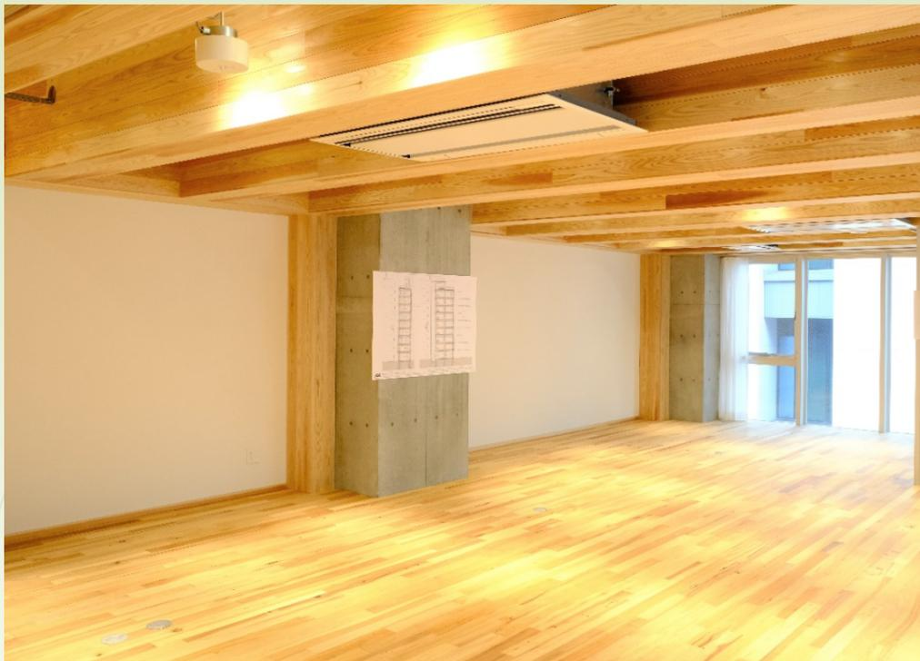
木の梁が現れるのは、構造上1・2階、4・5階、7・8階で、3・6・9階がRC造の梁となります。メガストラクチャーのダイナミックなSRC造の柱に木造の柱が寄り添うように建っているのが分かります。見えている梁部分は約500mm、梁下は約2.3mです。
