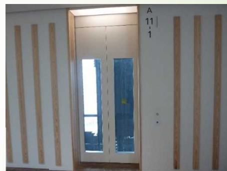
エレベーター周辺や階段の木材使用
