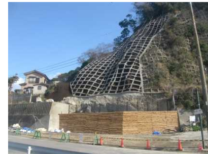
治山工事(法枠工外)実施済箇所 (小湊萩山国有林)
