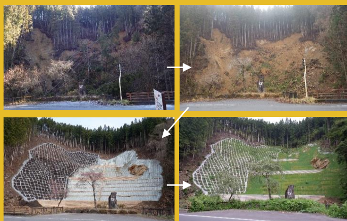
治山事業完成までの様子
