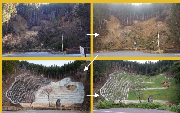
治山事業完成までの様子
