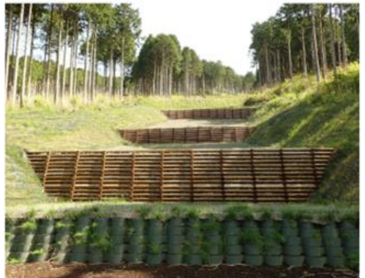
木製(校倉)土留工 (小山地区(綱山2))
