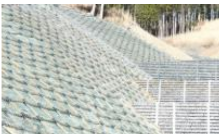
木製法枠工 (小山町地区)
