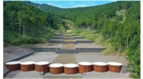
（大御神2）鋼製セル床固工・鋼製枠床固工
