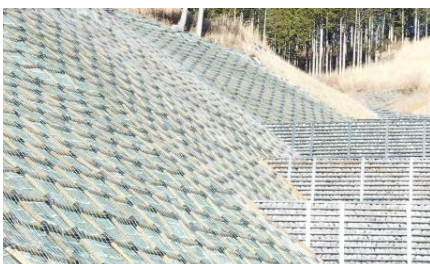
木製法枠工（小山町地区）
