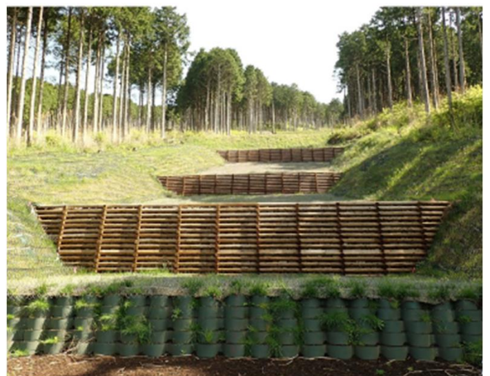
木製（校倉）土留工（小山地区（綱山2））
