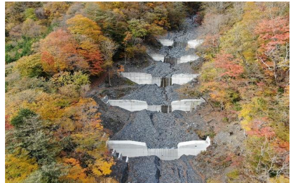
静岡市井川湖上流区域 東河内（溪間工）
