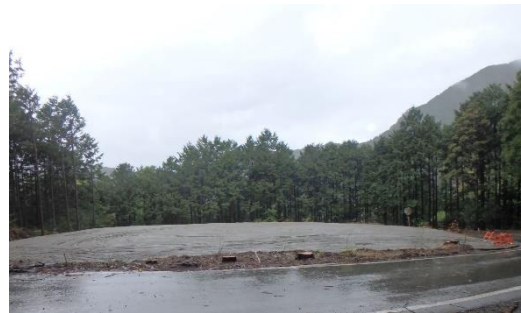
黒俣地域における国有林内に作設されたストックヤード （天竜署：掛川市）
