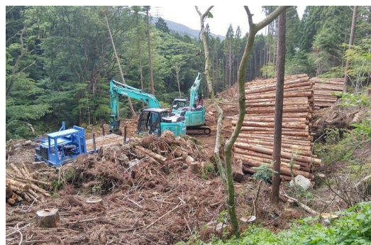
伐採状況（静岡署：御殿場市）
