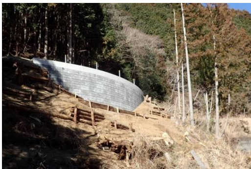
小山町における民有地での林道改良工事 （静岡署：小山町）
