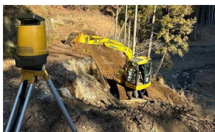
杭北 LN-150を活用した床掘（林道）
