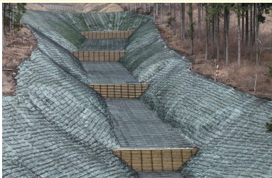
木製土留工 （静岡署：小山町）
