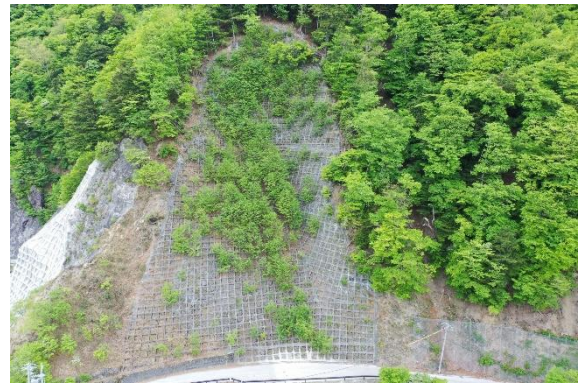
復旧状況 R8（2026）
