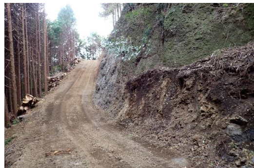
国有林林業専用道から延長された民有林作業道 （伊豆署：松崎町）
