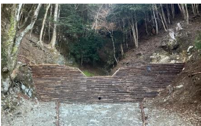
丸太残存型枠工 （伊豆署：河津町）
