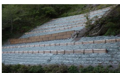
丸太筋工 （大井川治山センター ：川根本町）
