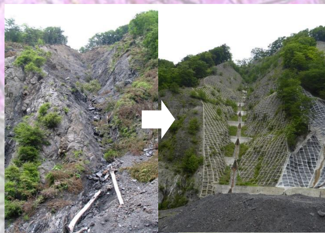
金沢（山腹工） (静岡市井川湖上流区域：大井川治山センター)
