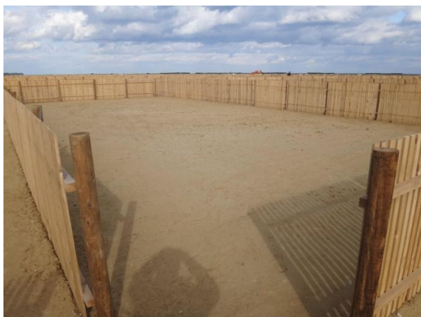
静砂垣（高さ：1.2メートル）
