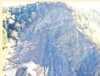
写真8.施工後半年の施工地→ 岩部は緑化が見られる (R7.10.23撮影)
