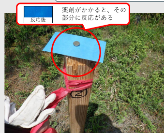
落下板設置状況
