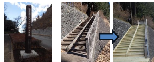
写真 2 木製標柱と木製階段
