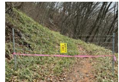
写真2 金網タイプの防護柵資材を活用(渋川担当区・前山林道)
