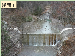
嵩上げ2基完了、1基新設中
