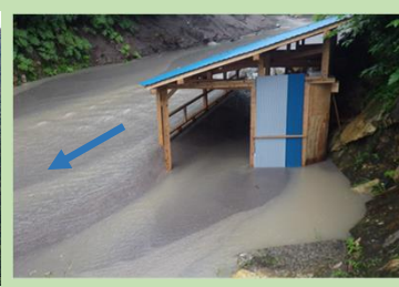
下流の天然温泉被災状況 (R3.8)
