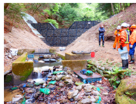
施工中の現地確認
