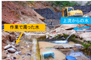
建設作業の様子
