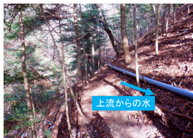
約200mに及ぶ仮設水道管
