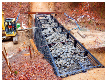
鋼製枠谷止工の詰石作業
