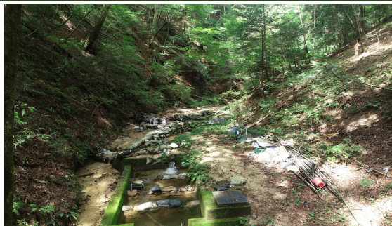
谷止工施工前の現地
