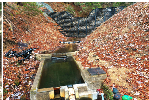
谷止工完成から半年後の現地
