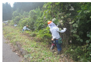
作業の様子（令和5年10月11日）
