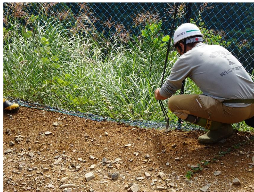
控えロープ補修(アンカー抜け)
