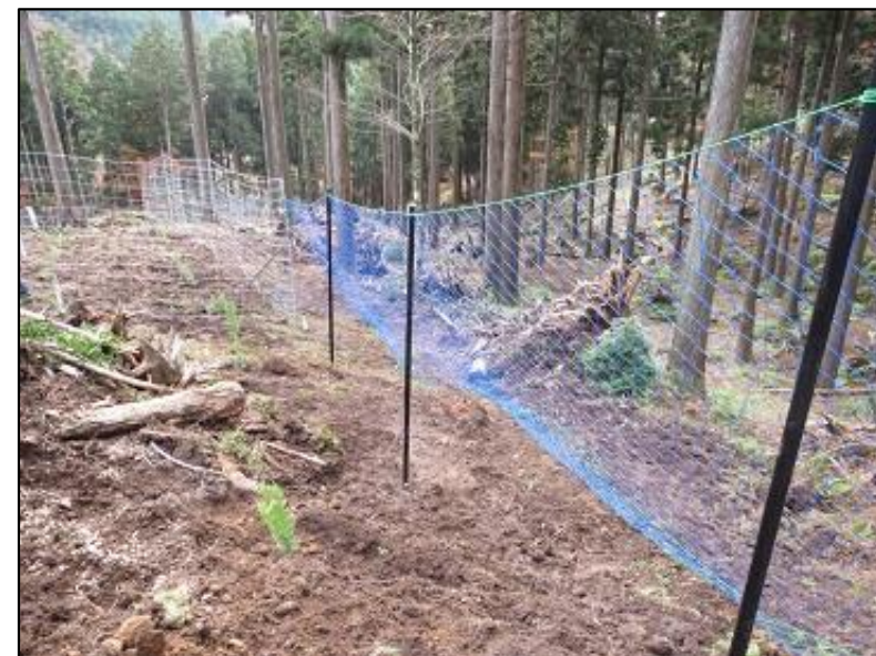
獣害防護柵の設置(ネット) (伊豆森林管理署)
