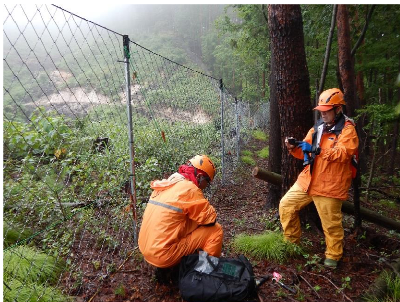
控えロープ補修、写真記録
