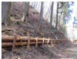
丸太筋工 斜面からの土砂等の流出防止
