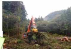
林業機械による地拵え
