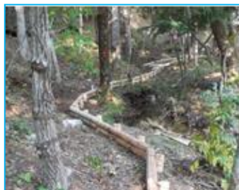
木柵工(田村市事業地)
