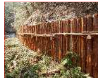
丸太伏工(川内村事業地)
