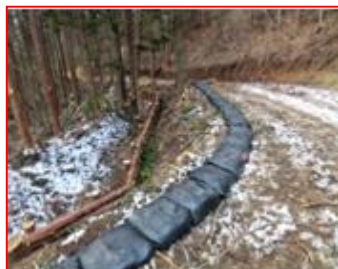
土のう工(田村市事業地)
