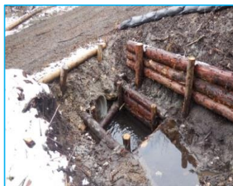
沈殿池(田村市事業地)
