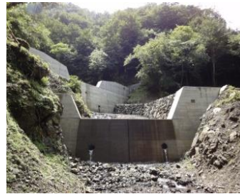
写真左:沢や谷の土砂の流出を防ぐ治山ダム(溪間工)
