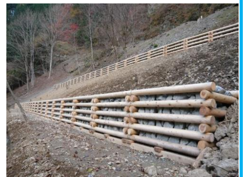
間伐材を使用した治山工事 (秩父市荒川上田野：中川国有林)
