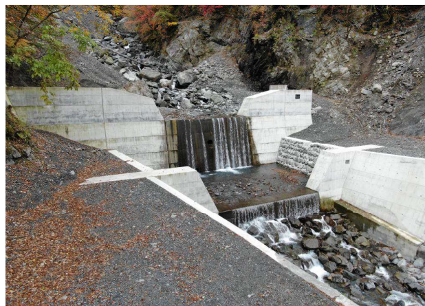
溪間工（外山沢【民有林】） （静岡市：大井川治山センター 令和7年度施工）
