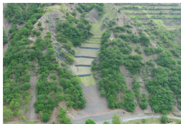
下桐久保沢地区復旧治山工事
