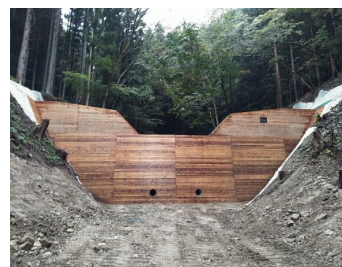
清水沢地区予防治山工事
