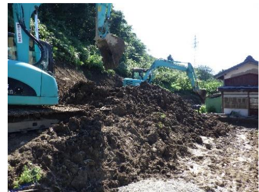
豪雨災害により民家に流出した土砂撤去作業
