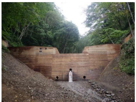
【国有林内治山対策箇所】木製残存型枠を使用したコンクリート谷止工
