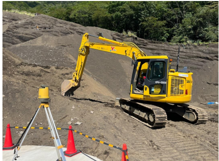
ICT建機（マシンガイダンス）による土工作業
