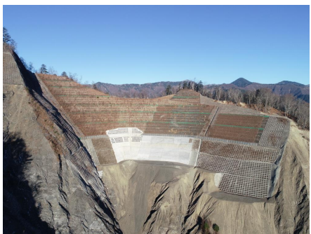
【民有林内治山対策箇所】大規模崩壊地の復旧状況
