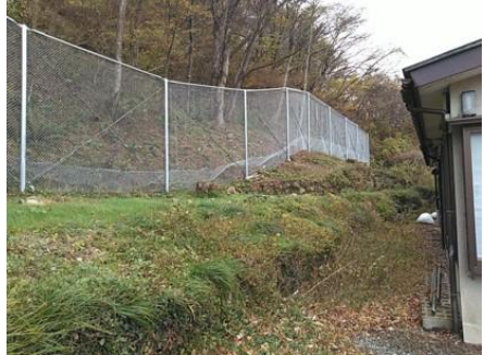
落石の恐れのある箇所の治山対策
