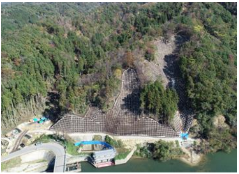
集中豪雨による被害箇所の 復旧状況（新潟県村上市）
