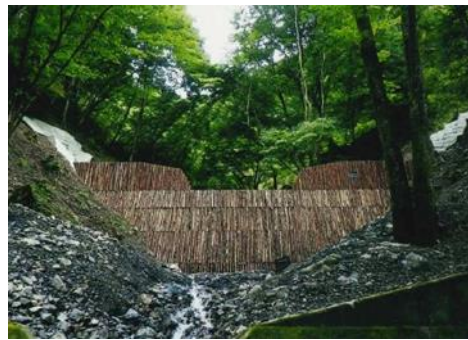
木製残存型柵を使用した コンクリート谷止工
