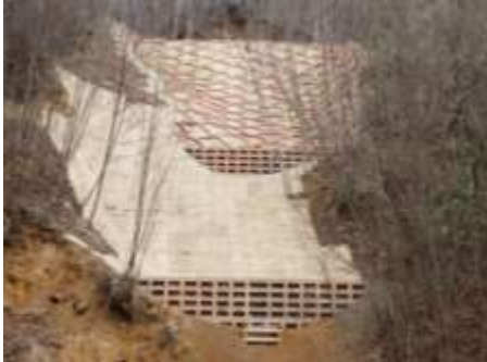
木材を使用したかご柵工と法柵工
