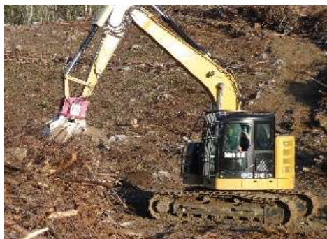
伐採と併行した枝条の片付け作業（地拵え）
