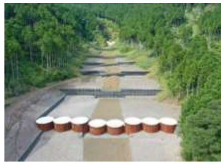
鋼製鉄板を使用した円形谷止工
