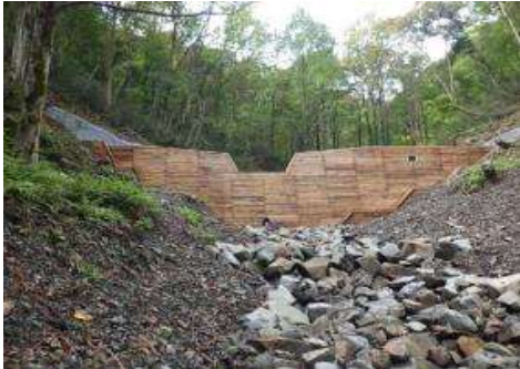
木製残存型柵を使用した コンクリート谷止工
