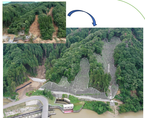
災害関連治山対策施工状況
