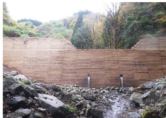
阿賀町 土倉山地区予防治山工事 （令和3年度施工） 木製残存型枠工の採用
