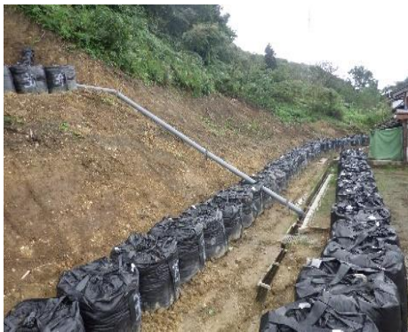
花立地区応急対策状況
