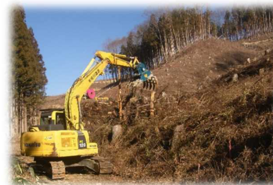
林業機械による地拵作業
