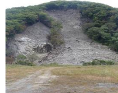
復旧治山工事（山腹工）
