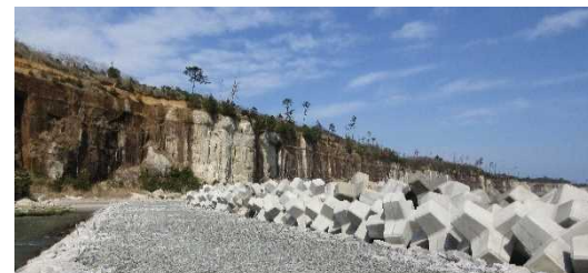
防災林造成工事（富岡町）
