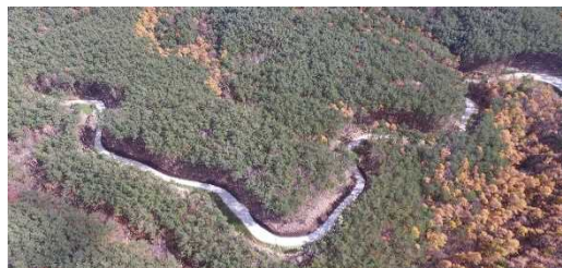
林業専用道新設工事（川内村）
