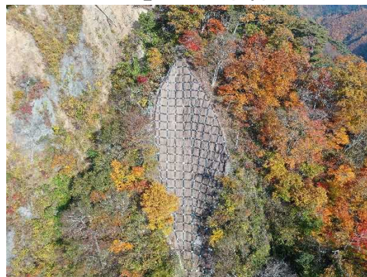
会津若松市大戸地区予防治山工事（ロッククライミング工法による山腹工）
