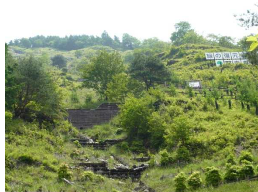
荒廃地の復旧(足尾地域)
