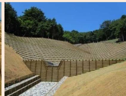
間伐材を利用した治山工事
