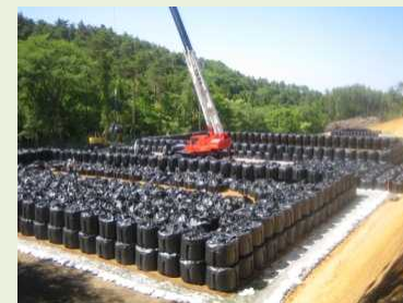
仮置場（福島県内国有林）
