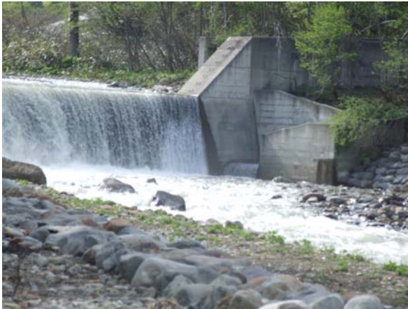
自然石を利用した護岸、治山ダムと魚道
