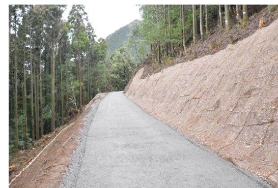
路網開設（滑沢支線林業専用道）
