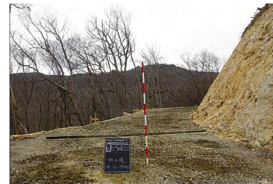
路網開設（水引林業専用道）
