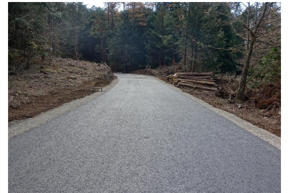
路網開設（大沢第二支線林業専用道）
