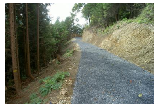
路網開設 (西ノ沢林業専用道)
